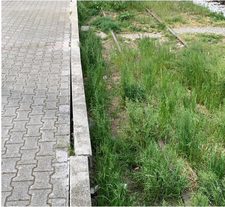
Fotografija 6: Dotrajanost peronske in tirne infrastrukture
