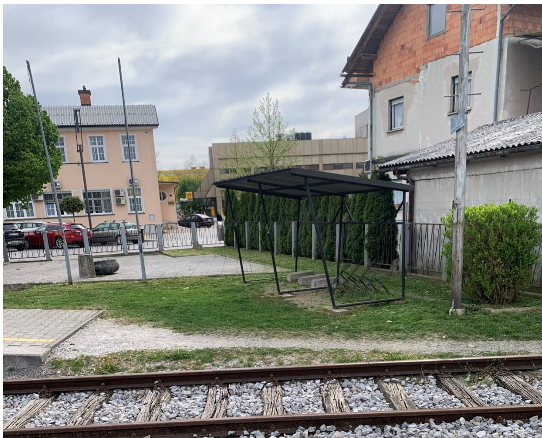
Slika 8: Obstoječa kolesarnica na železniški postaji Domžale
